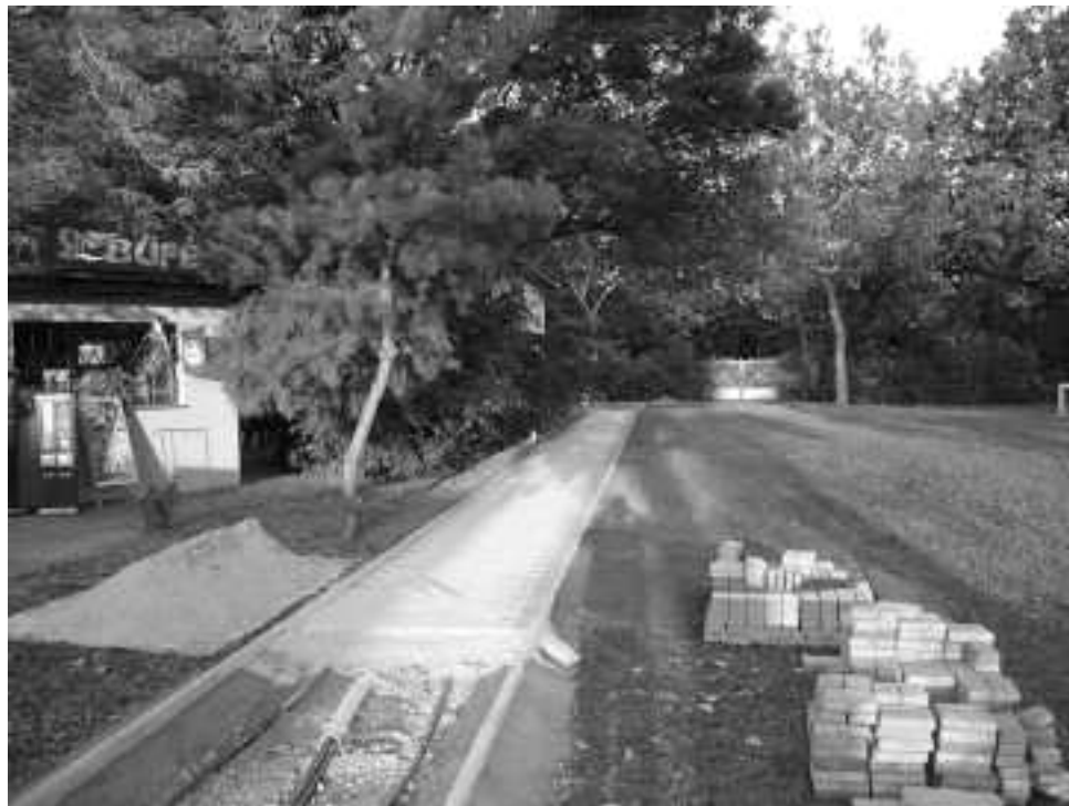
Épül a téli összekötő folyosó járófelülete a turisztikai fogadóépület és a termálmedence között
